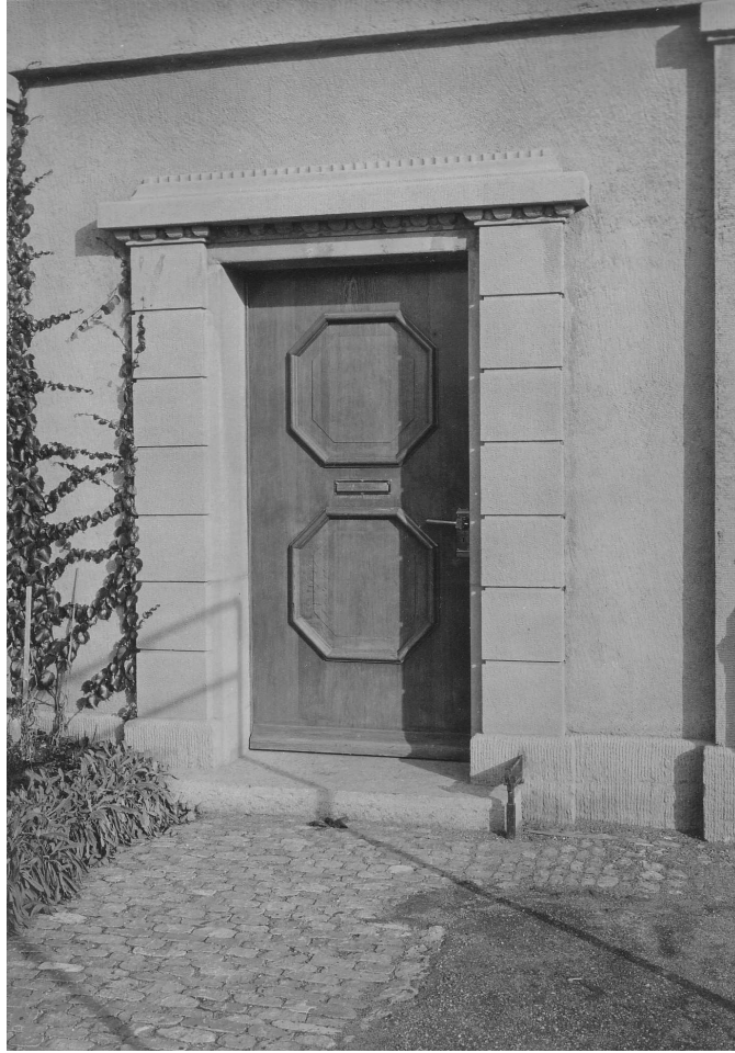
Abwartwohnung Eingang West
