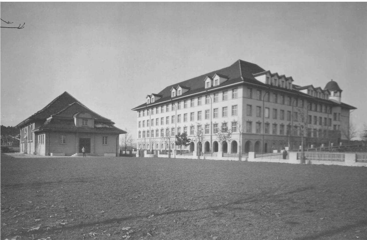
Gesamtansicht mit Süd- & Ostfassade
