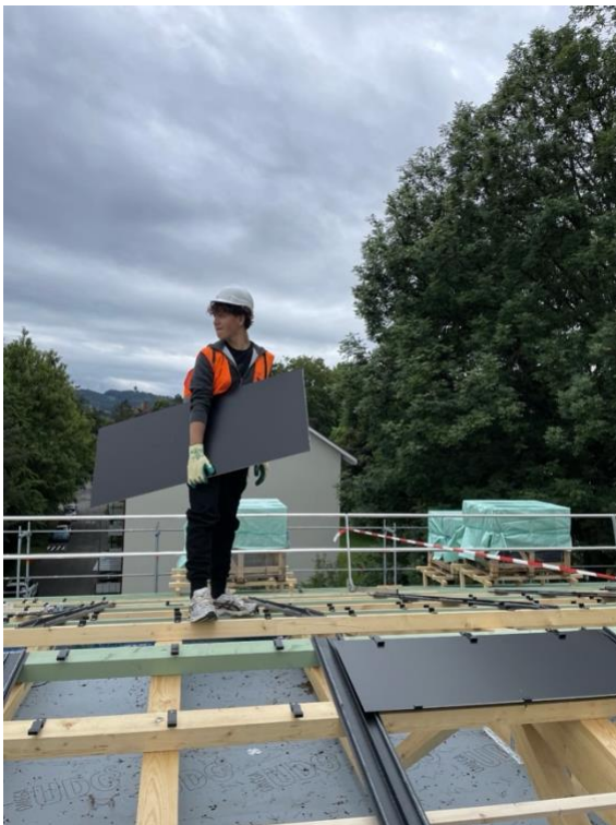
Montage der Solarpanels auf dem Dach des Schulhauses Schlossmatt
